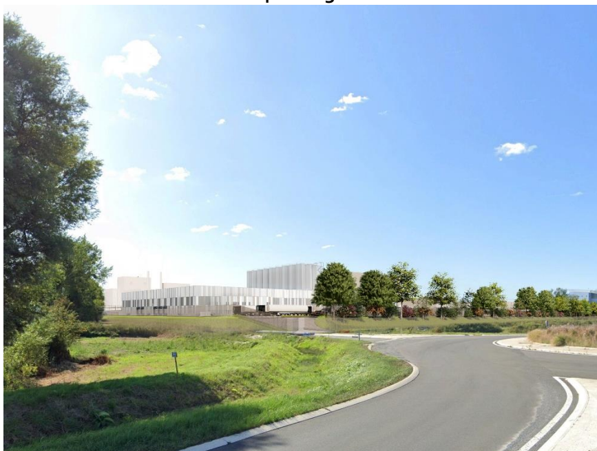
Vue aérienne depuis la route Sud
